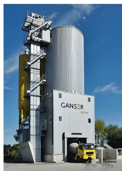
Das Betonwerk in Aubing
