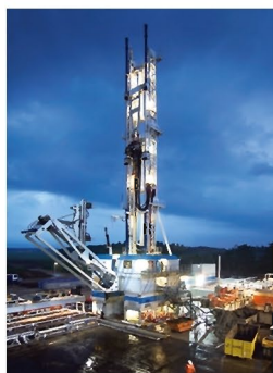
Der Geothermie-Bohrturm in Dürrenhaar
